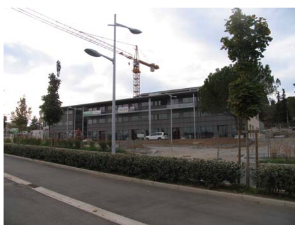
新興住宅地で建設途上の建物 (国際学校向かいの商業施設)
