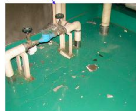
割がれ落ちた破片
