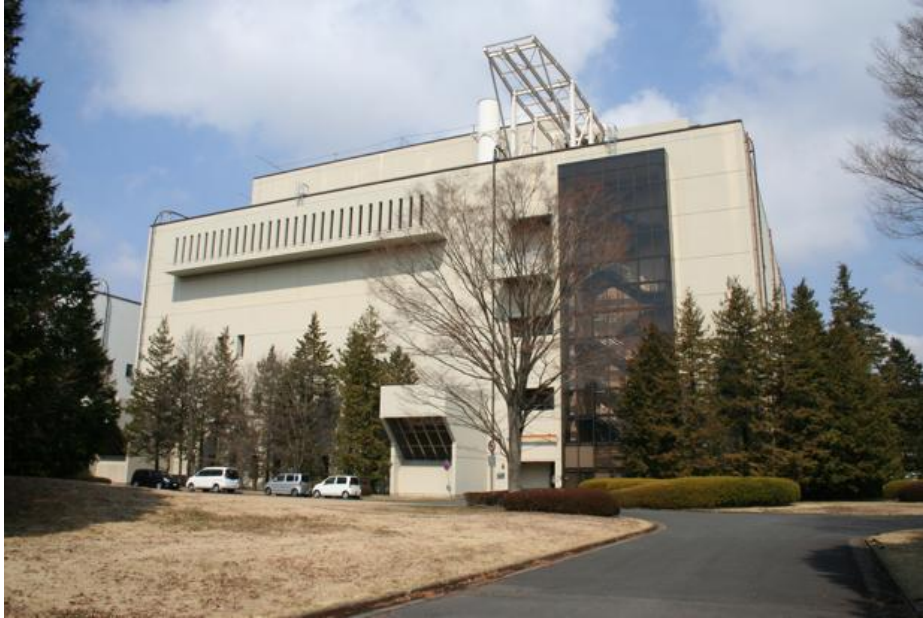
JT-60実験棟の外観
