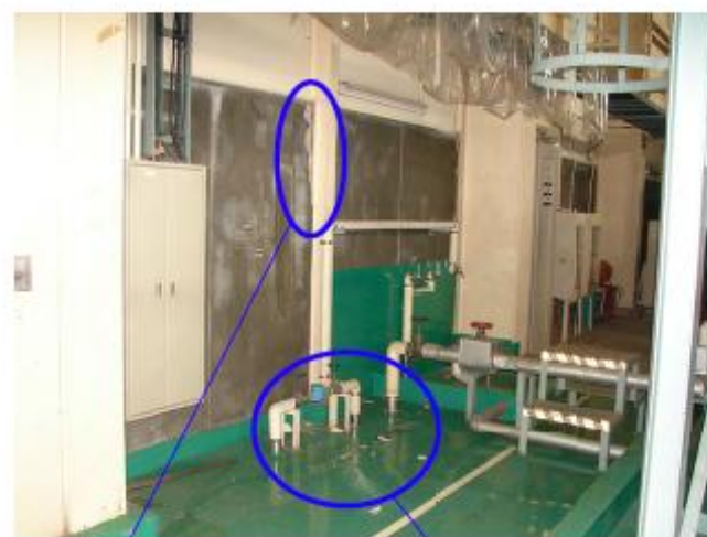
一次冷却棟内腰壁コンクリートの割れ (建屋全周に亘って腰壁両端に割れが発生、写真は北側腰壁)
