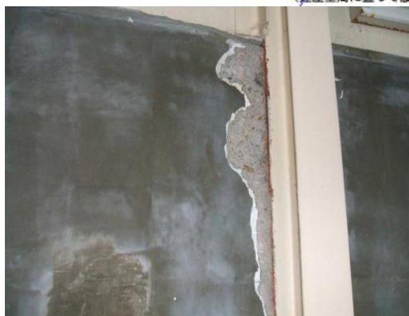
一次冷却棟内腰壁コンクリートの割れ (建屋全周に亘って腰壁両端に割れが発生、写真は北側腰壁)
